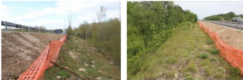
Exemple concret de mise en défens à l'aide de filet de protection sur un chantier autoroutier (A11, Cofiroute) – © THEMA Environnement, 2012
